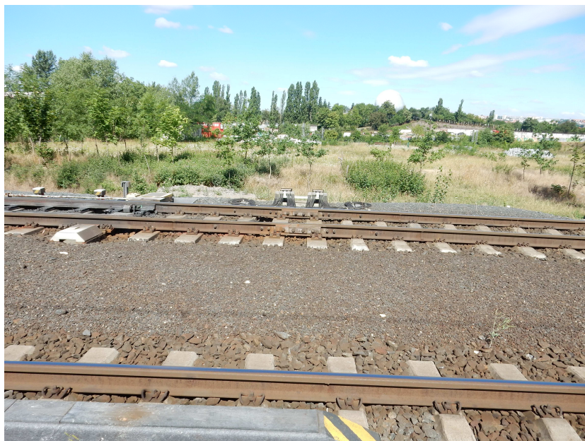
Foto 15 - Nové připojení odvodu zpětného proudu u hrotu výhybky č.1
