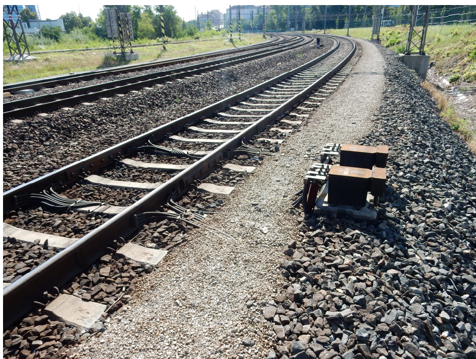
Foto 6 – Odvod zpětného proudu mezi KO 1HS-IK a KO 1HSK
