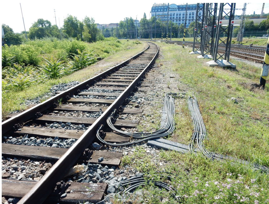
Foto 9 - Odvod zpětného proudu z výtahné koleje B
