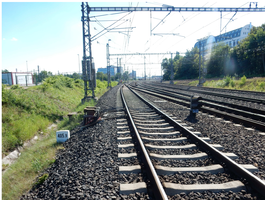
Foto 5 – Odvod zpětného proudu mezi KO V80 a KO 2MSK
