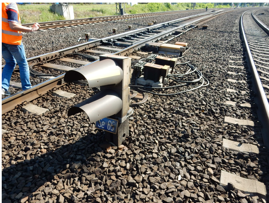
Foto 4 – Odvod zpětného proudu mezi V82 a KO V83
