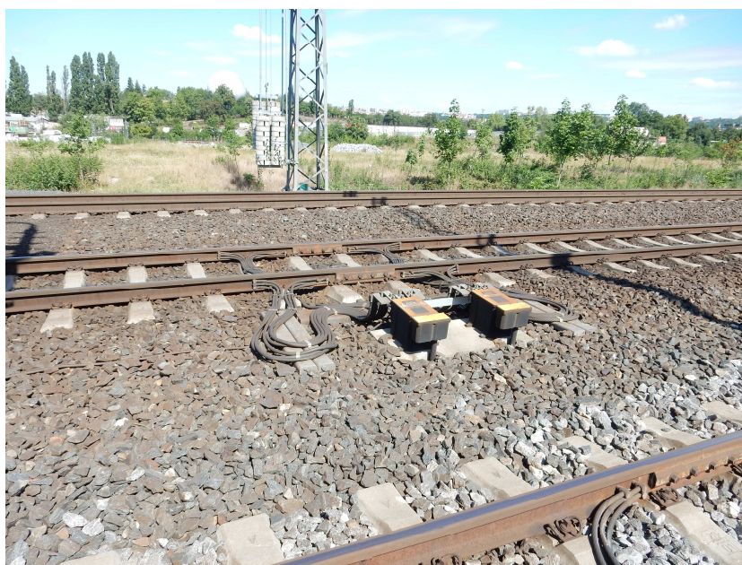
Foto 14 - Nové připojení odvodu zpětného proudu u návěstidla 302L
