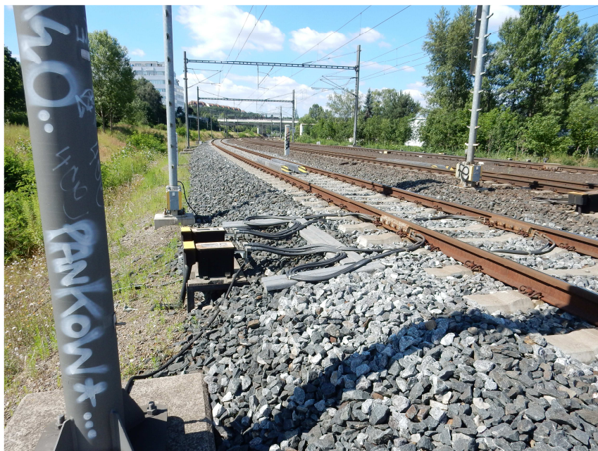
Foto 13 – Nové připojení odvodu zpětného proudu u návěstidla 401ML
