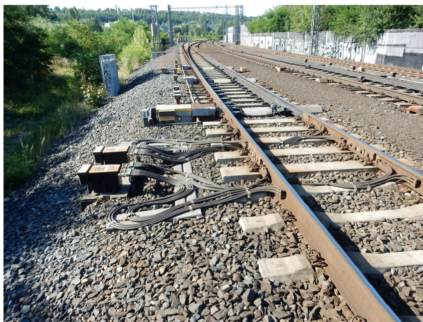
Foto 10 – Odvod zpětného proudu mezi KO V4 a KO 302K, které se demontuje
