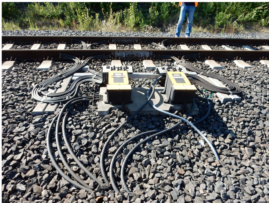
Foto 2 – Odvod zpětného proudu mezi KO 103cK a KO 103c-86K
