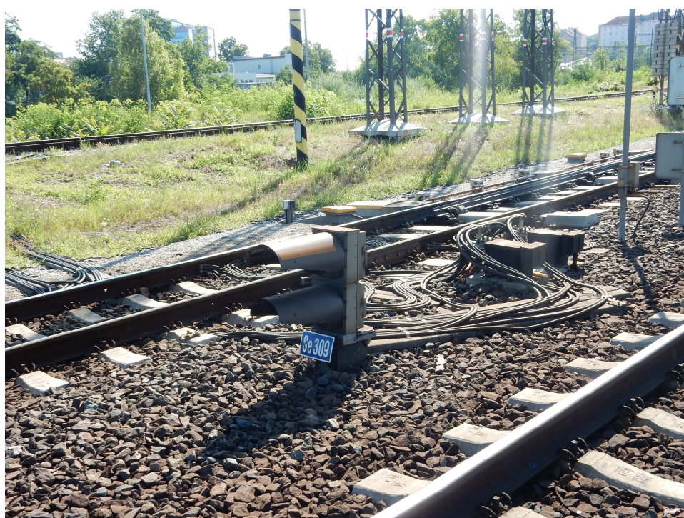
Foto 8 - Odvod zpětného proudu mezi KO V81 a KO VSK
