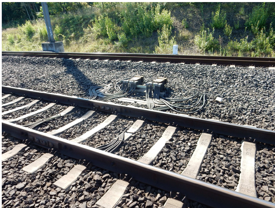
Foto 3 – Odvod zpětného proudu mezi KO 101aK a KO 101a-84K
