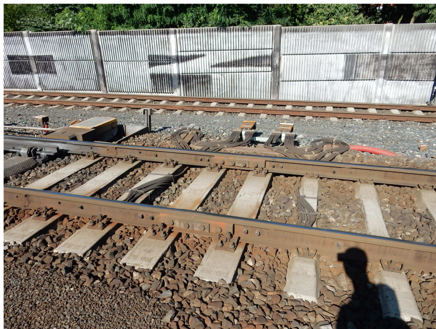
Foto 11 – Odvod zpětného proudu mezi KO V5 a KO 301K, které se demontuje
