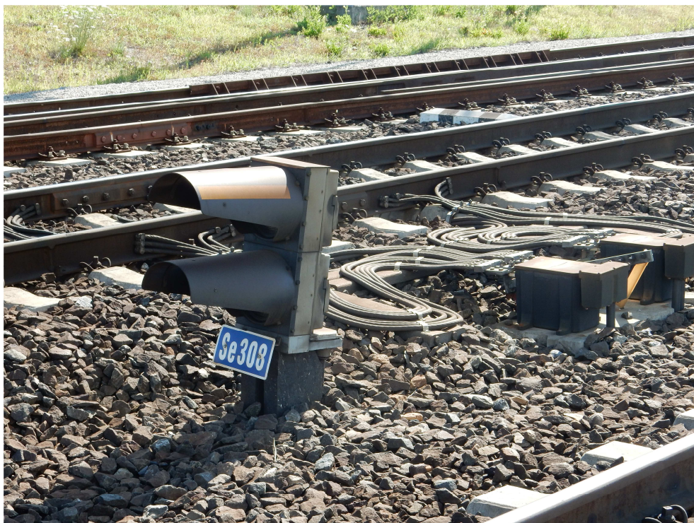
Foto 7 - Odvod zpětného proudu mezi KO V77 a KO 2HSK
